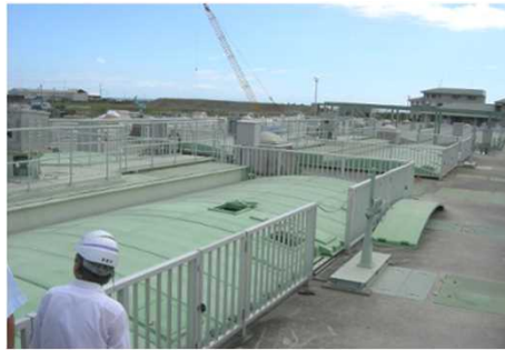
はんのうそう 反応槽とよばれる池 池はフタでおおわれていますが、 11～12ページの処理2(び生物 での処理)をしている池です。
